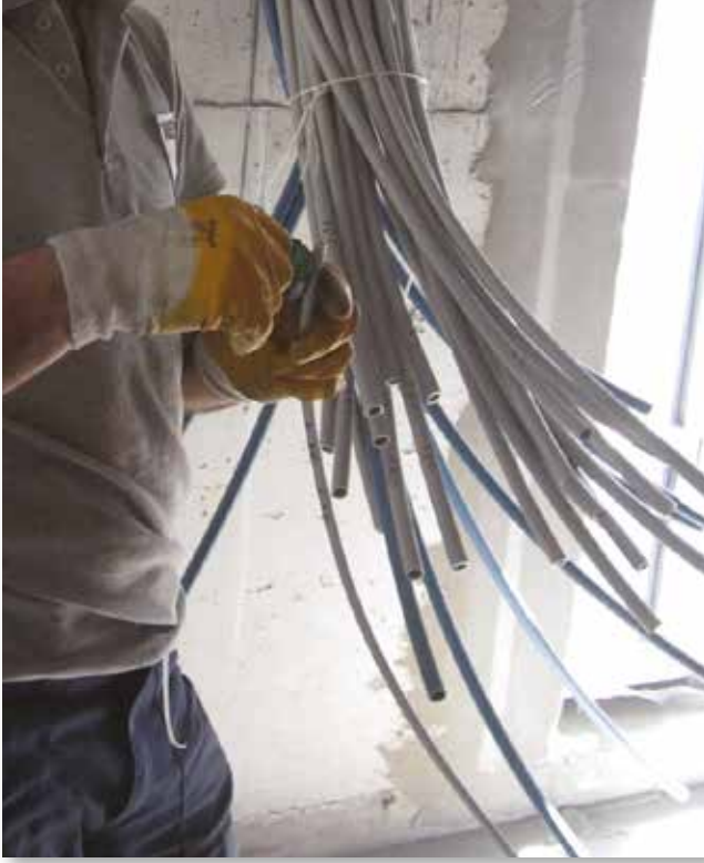
Kabloların montaj esnasında uçlarını açmakta olan bir operatör.
